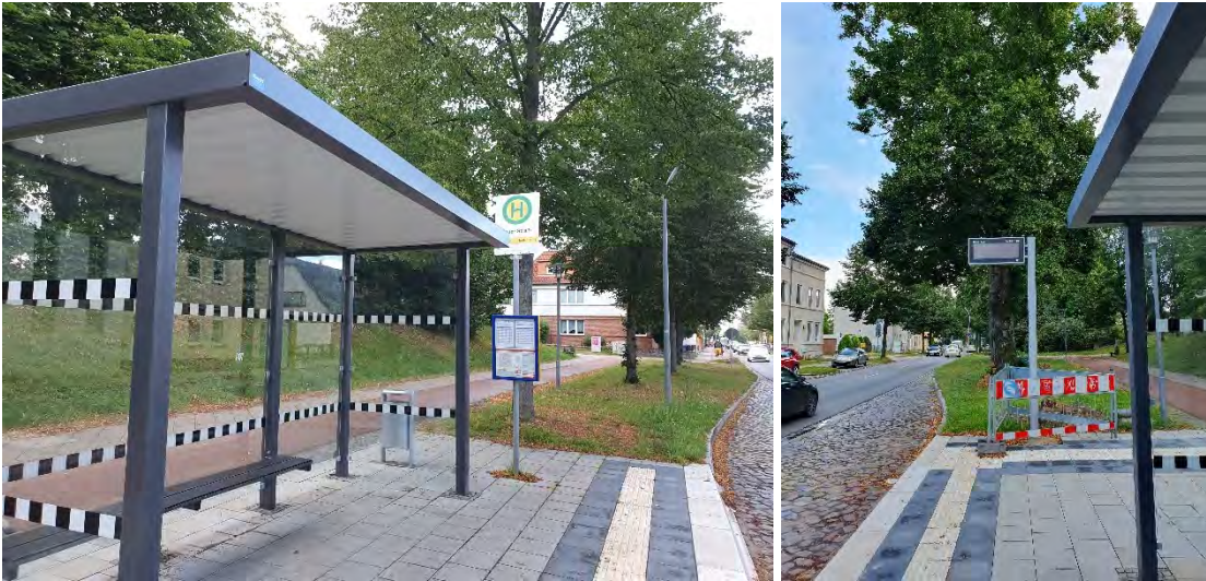
Abbildung 86: Barrierefrei ausgebaute Haltestelle „Plauer Straße“ (stadteinwärts) mit Fahrgastunterstand und Sitzmöglichkeit, Sonderborde, Bodenindikatoren, Fahrplanaushang, Abfalleimer sowie zusätzlicher digitaler Anzeigetafel (Quelle: ZEBAU GmbH)
