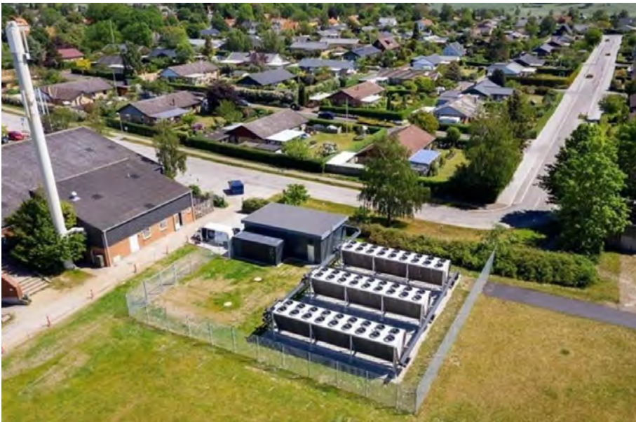
Abbildung 44: 1 MW th Luftwärmepumpe in Dänemark (Urheber PlanEnergi)
